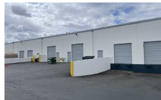
1 GRADE-LEVEL DOOR & 1 DOCK-HIGH DOOR
