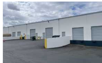
1 GRADE-LEVEL DOOR & 1 DOCK-HIGH DOOR
